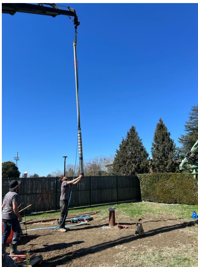
Figure 7 : Descente de la pompe ainsi que de la colonne d'exhaure pour l'essai de pompage
