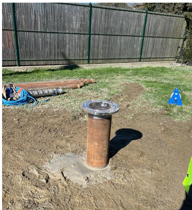
Figure 6 : Puits cimenté avec le tube de protection
