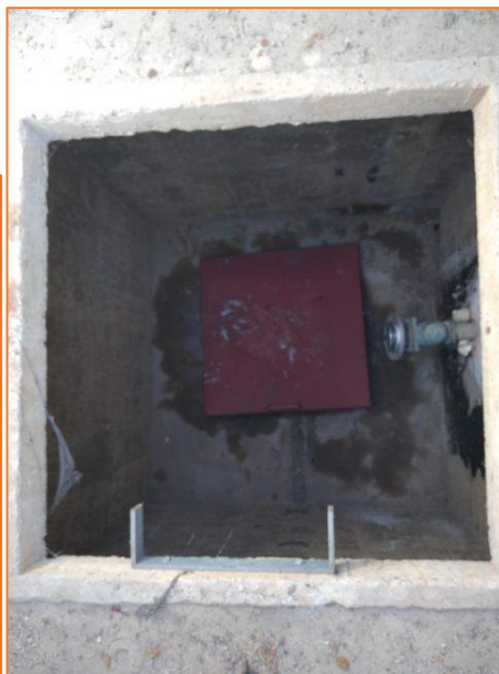
Figure 2 : Nettoyage de l'avant puits et déconstruction de la réhausse (Source : Verdipole)
