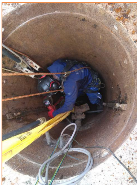
Figure 2 : Découpe des colonnes via cordistes (Source : Verdipole )
