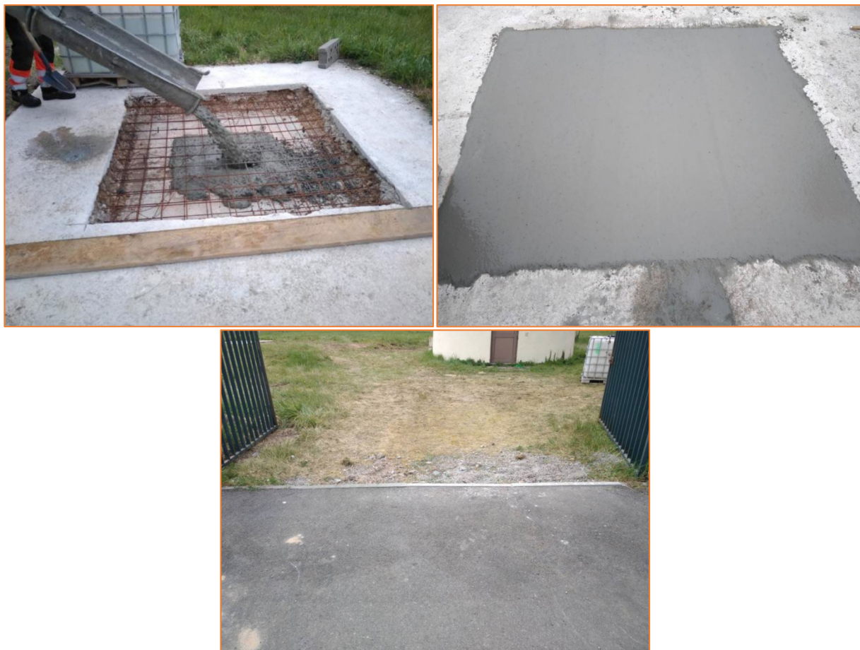
Figure 1 : Coulage de la dalle sur Saint André de l'Eure et remise en état des bordures en entrée de zone (Source : Verdipole )
