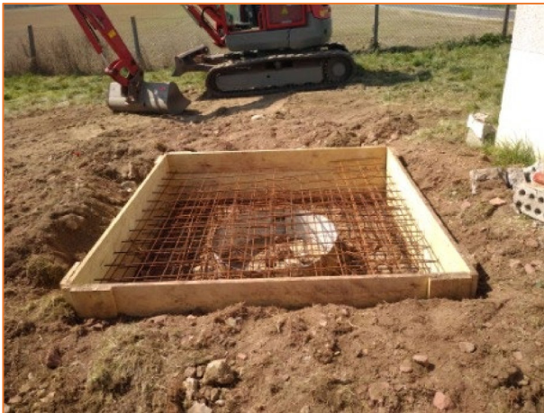
Figure 1 : Fin des opérations de préparation des dalles au droit des forages de Cisse et Saint André de l'Eure (Source : Verdipole)
