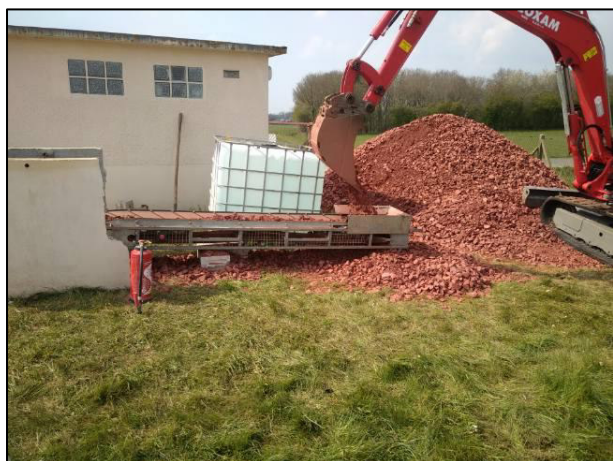
Photographie 5 : Mise en place du massif filtrant (source : Verdipole)
