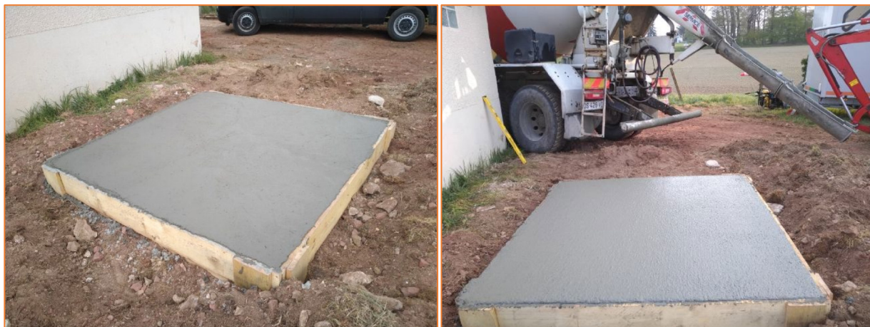
Figure 2 : Coulage de la dalle sur Cisse (Source : Verdipole )
