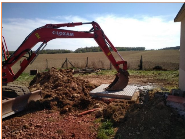
Figure 2 : Début des opérations de terrassement en prévision de la création de la future dalle et sécurisation de la zone en fin de journée (Source : Verdipole )
