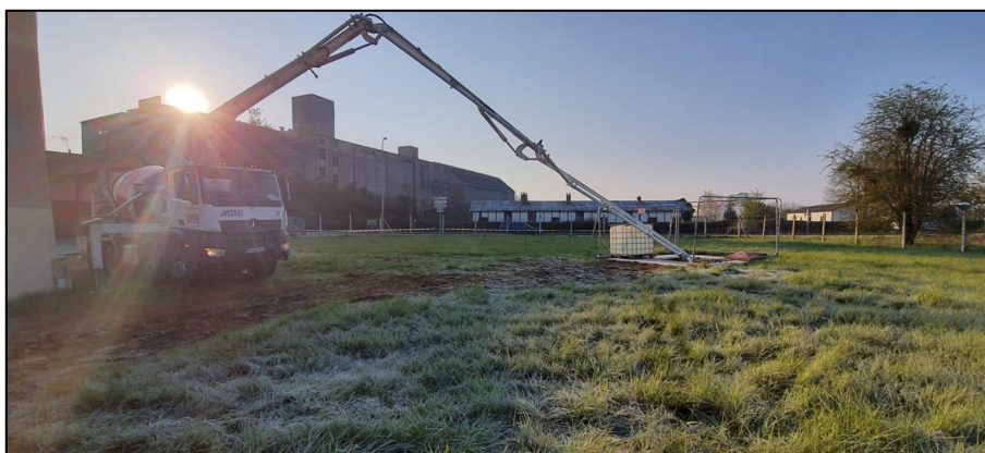
Photographie 15 : Mise en place du bouchon de cimentation en partie supérieure de l'ouvrage (source : Verdipole )
