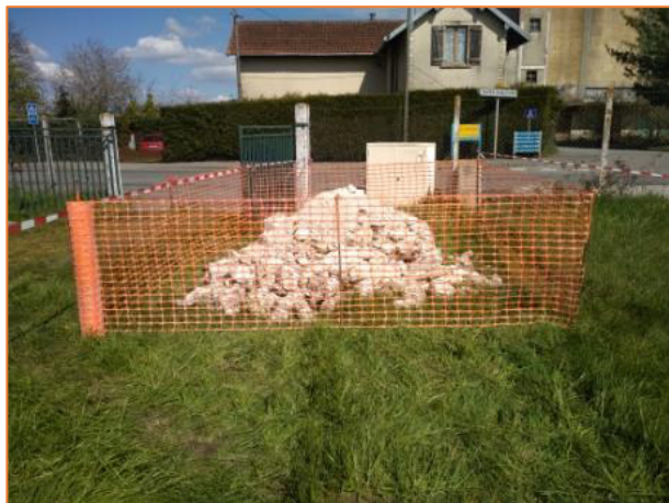
Figure 2 : Nettoyage de l'avant puits et déconstruction de la réhausse (Source : Verdipole)
