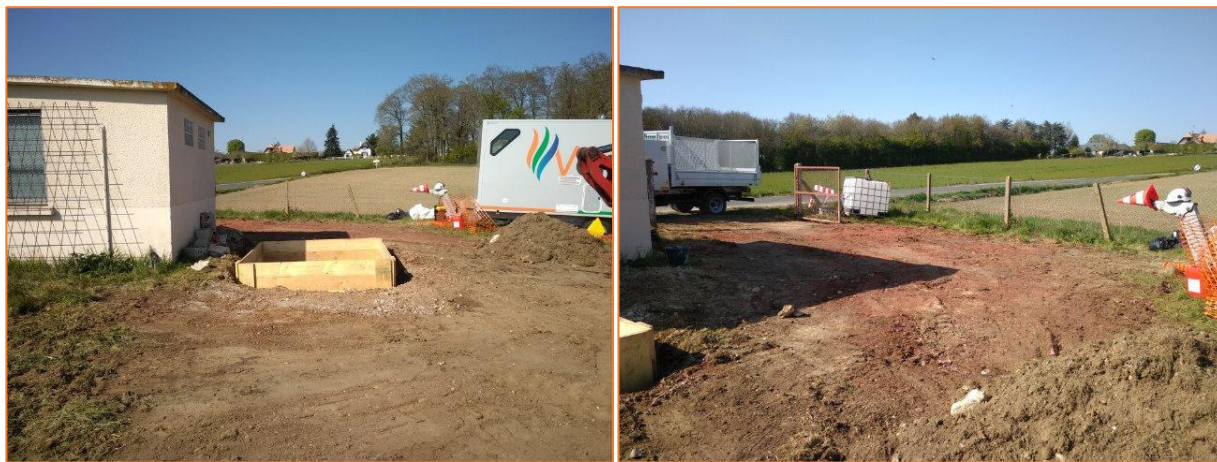
Figure 1 : Coffrage délimitant la future dalle et nettoyage des extérieurs (Source : Verdipole)
