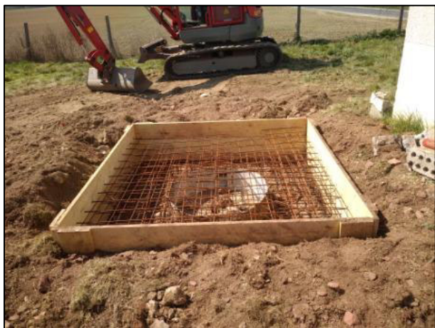
Photographie 8 : Coffrage et ferrailage de la dalle en béton (source : Verdipole)
