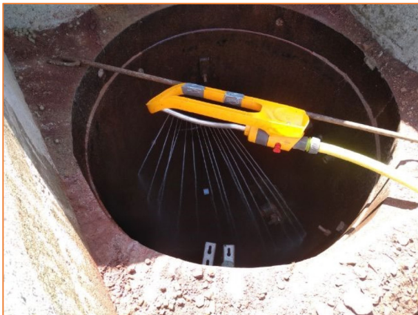
Figure 2 : Humidification de l'argile jusqu'à saturation (Source : Verdipole )
