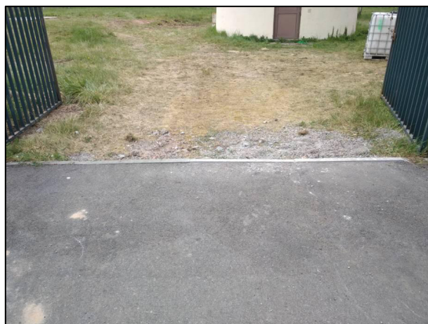
Photographie 16 : Réfection des bordures en entrée du site (source : Verdipole)
