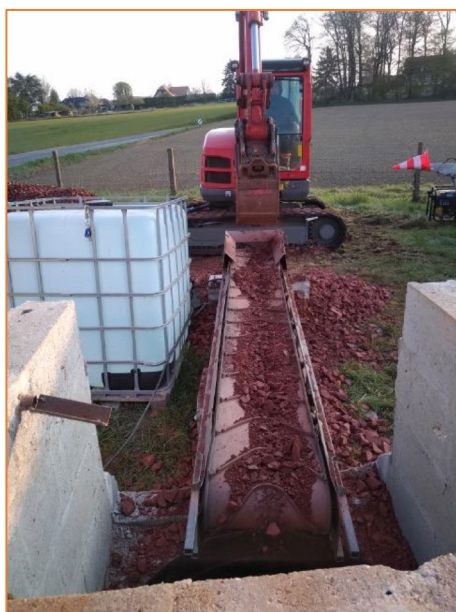
Figure 1 : Poursuite et fin du remblaiement du captage via l'utilisation de matériaux drainants (Source : Verdipole )
