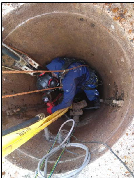
Photographie 3 : Retrait des équipements au sein de l'ouvrage par cordiste (source : Verdipole)
