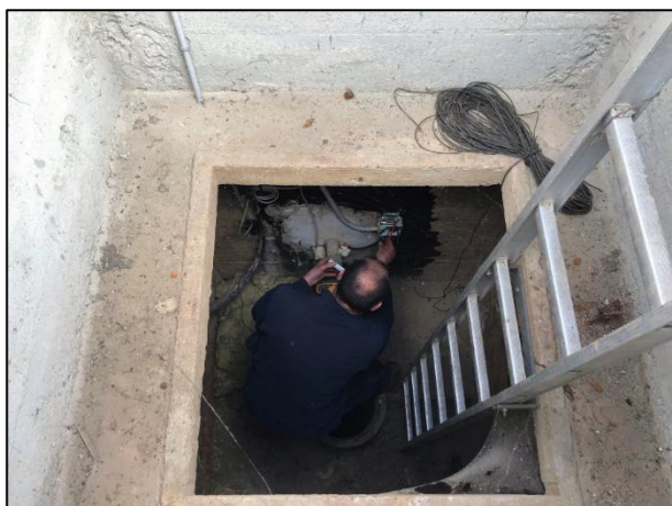
Photographie 13 : Contrôle de l'absence de tension au sein de l'ouvrage réalisée par la société STGS (source : Verdipole )
