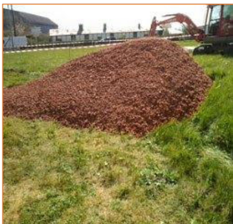
Figure 3 : Livraison des matériaux 0/31.5 et début des opérations de comblement (Source : Verdipole)
