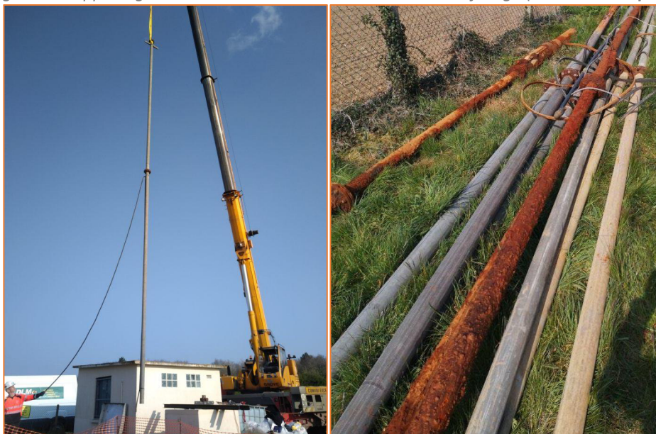
Figure 4 : Extraction des colonnes et dépôt sur site (Source : Verdipole )
