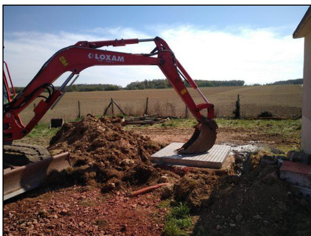
Photographie 7 : Sécurisation de l'ouvrage en cours de comblement en dehors des heures d'activité (source : Verdipole)
