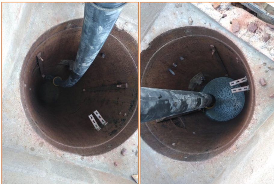
Figure 2 : Mise en place du coulis au sein de l'ancien forage (Source : Verdipole)
