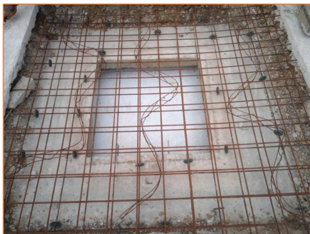
Figure 1 : Fin des opérations de préparation des dalles au droit des forages de Cisse et Saint André de l'Eure (Source : Verdipole)
