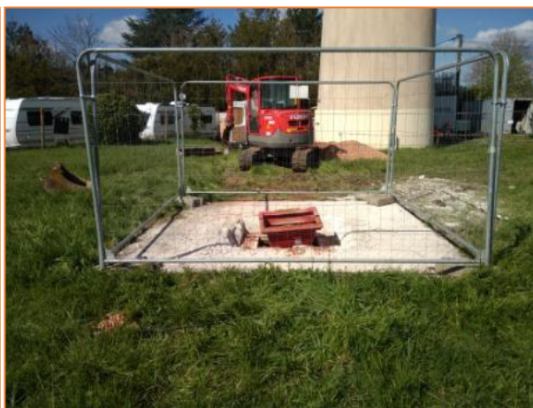
Figure 3 : Livraison des matériaux 0/31.5 et début des opérations de comblement (Source : Verdipole)
