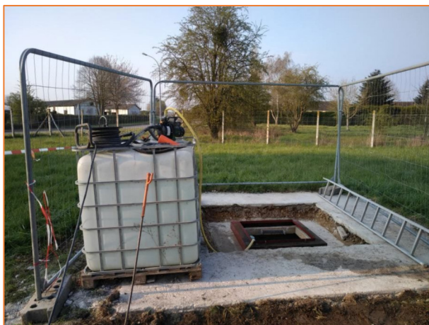
Figure 1 : Poursuite et fin des opérations de mise en place du bouchon d'argile (Source : Verdipole)
