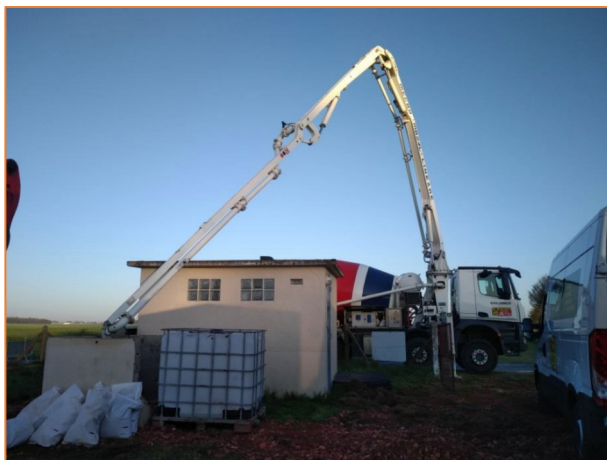
Figure 1 : Stationnement du mixo-pompe et début des opérations d'injection du coulis (Source : Verdipole)
