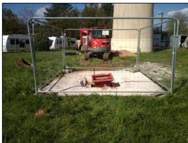
Photographie 12 : Sécurisation de l'ouvrage en cours de comblement (source : Verdipole )
