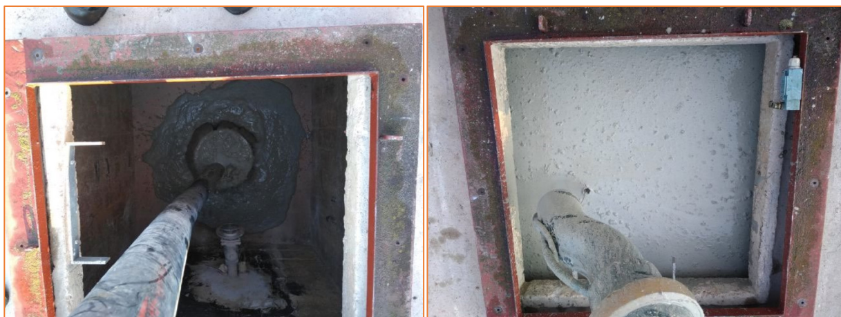
Figure 3 : Mise en place du coulis de cimentation (Source : Verdipole)
