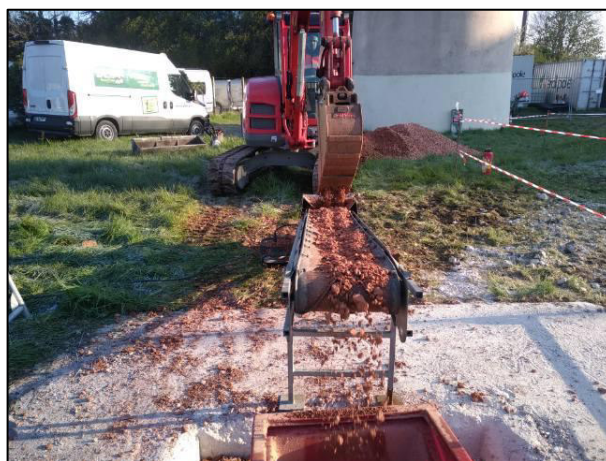
Photographie 14 : Mise en place du massif filtrant (source : Verdipole )
