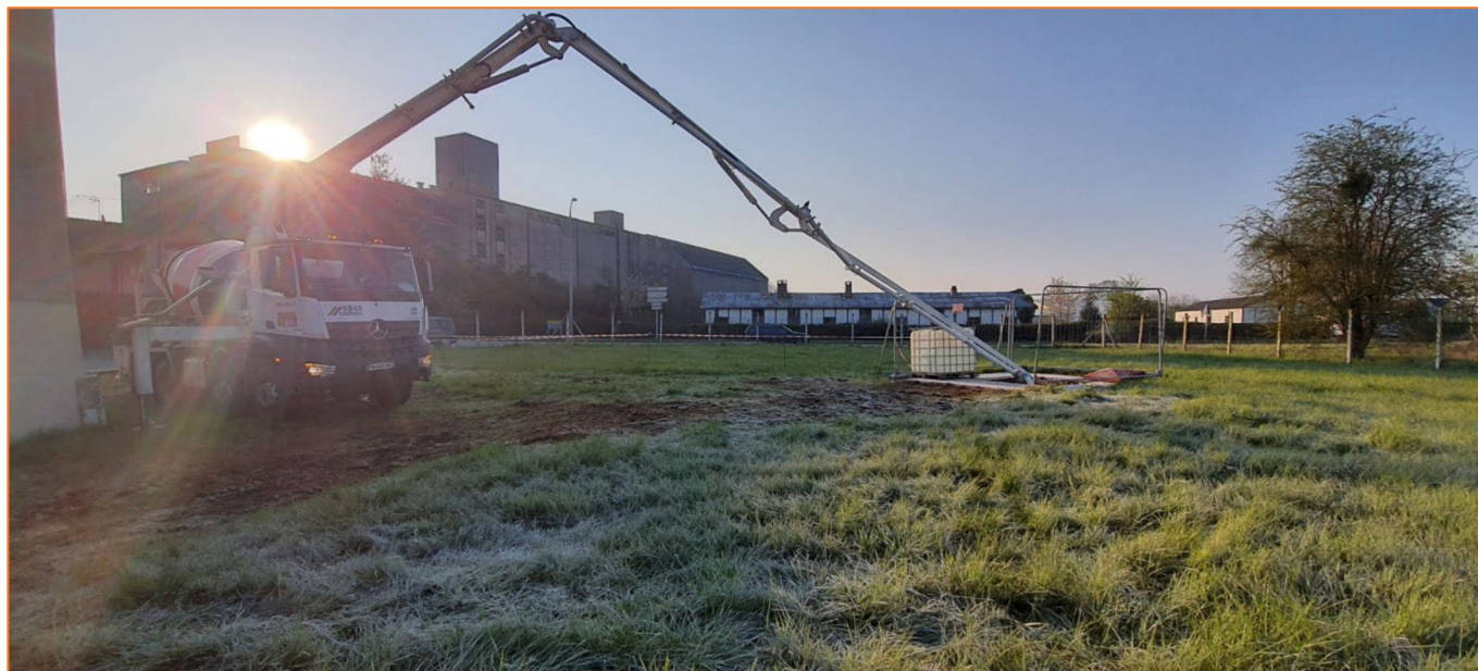
Figure 2 : Stationnement de l'ensemble et déploiement du bras permettant la dépose du coulis sur le bouchon d'argile (Source : Verdipole)
