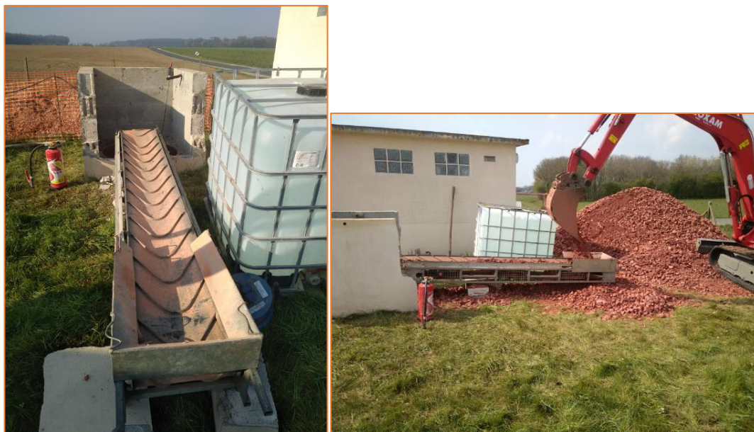
Figure 1 : Remblaiement du captage via l'utilisation de matériaux drainants (Source : Verdipole)
