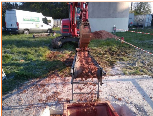
Figure 1 : Poursuite et fin des opérations de comblement à l'aide de matériaux drainants (Source : Verdipole)
