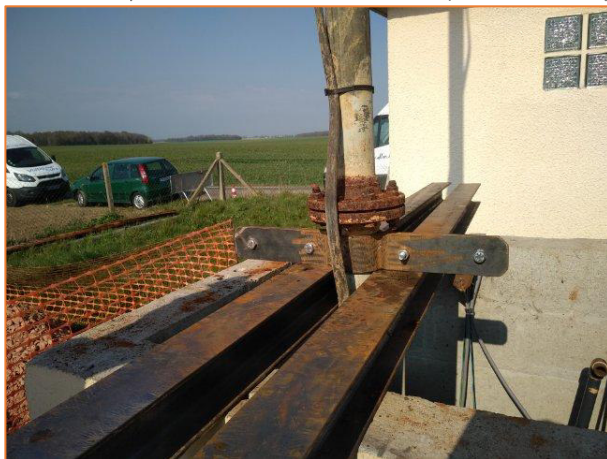
Figure 3 : Supportage des conduites en attente d'extraction du forage (Source : Verdipole )
