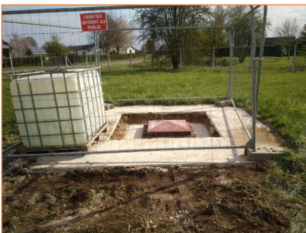
Figure 3 : Nettoyage de la dalle et préparation en prévision des opérations finales (création d'une dalle en surface) (Source : Verdipole )
