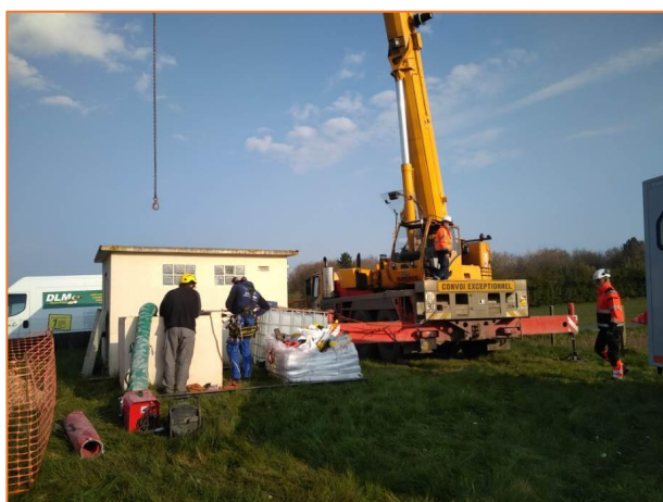
Figure 1 : Mise en place de la grue et des accessoires nécessaires aux opérations (ici visible sur la photo l'extracteur d'air) – prise de gaz à chaque pénétration au sein de l'ouvrage (Source : Verdipole)
