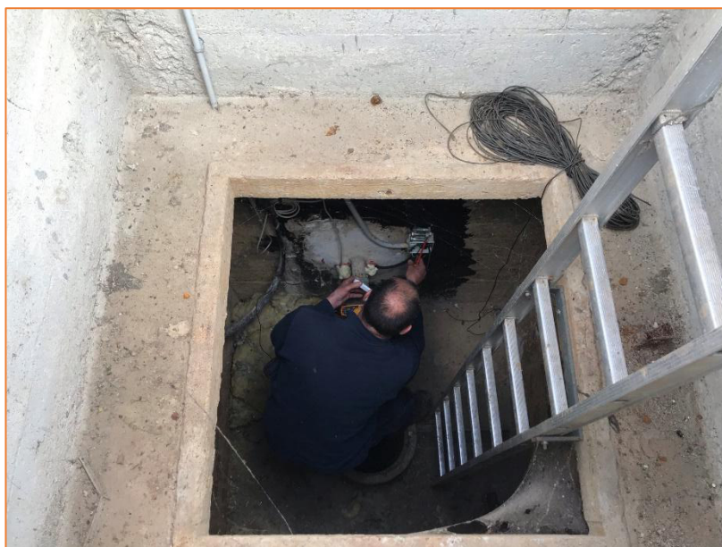
Figure 3 : Intervention STGS pour vérification alimentation électrique coffret au sein de l'avant puits (Source : Verdipole)
