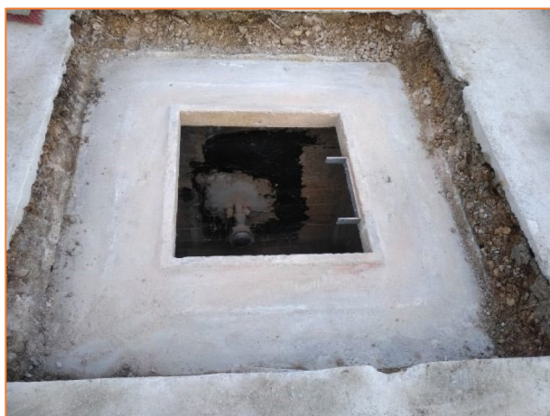
Figure 3 : Nettoyage de la dalle et préparation en prévision des opérations finales (création d'une dalle en surface) (Source : Verdipole )
