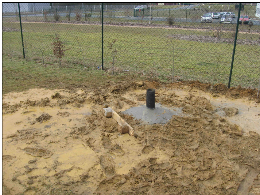
Figure 6 : fin d'implantation du piézomètre Pz 2
