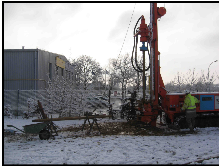
Figure 5 : Mise en station sur le piézomètre Pz 1
