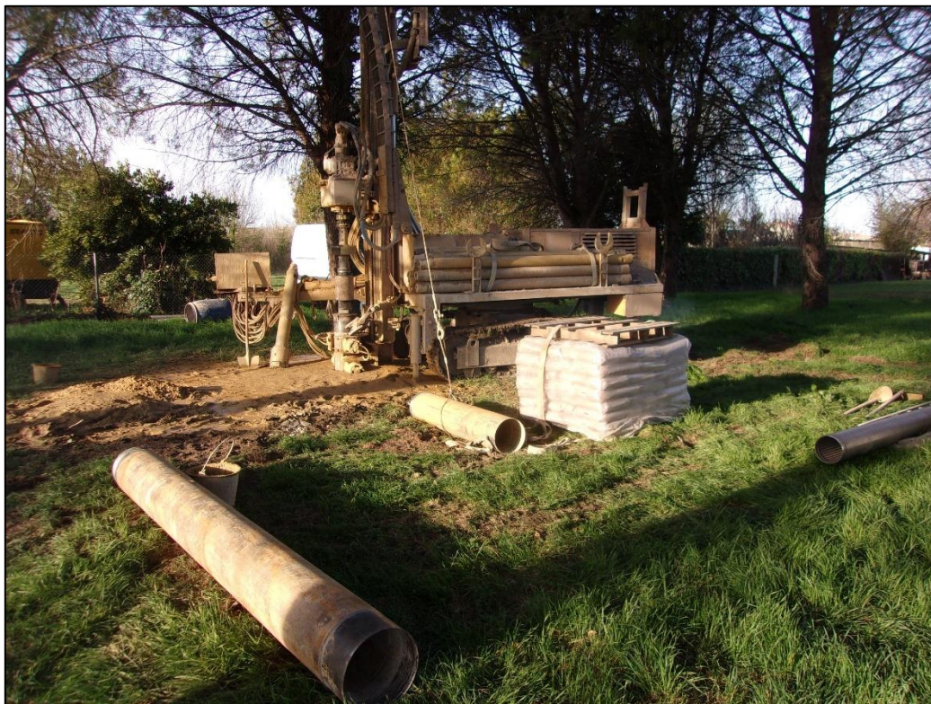
Figure 5 : Chantier de foration
