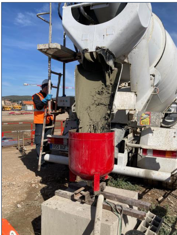
Figure 5 : Mise en place du coulis de ciment
