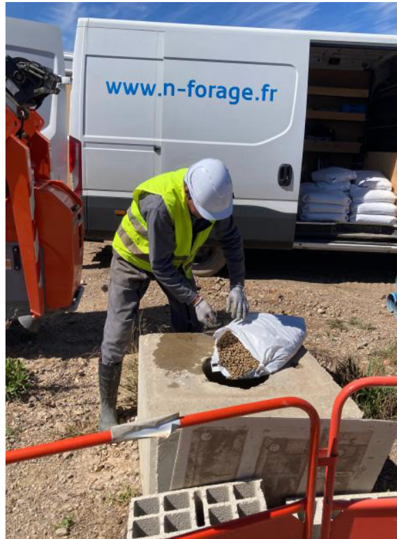
Figure 4 : Mise en place du bouchon d'argile
