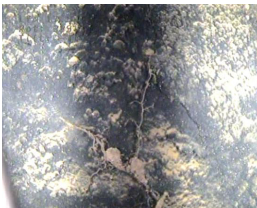
Profondeur : 17,9 m Tube légèrement desquamé.
