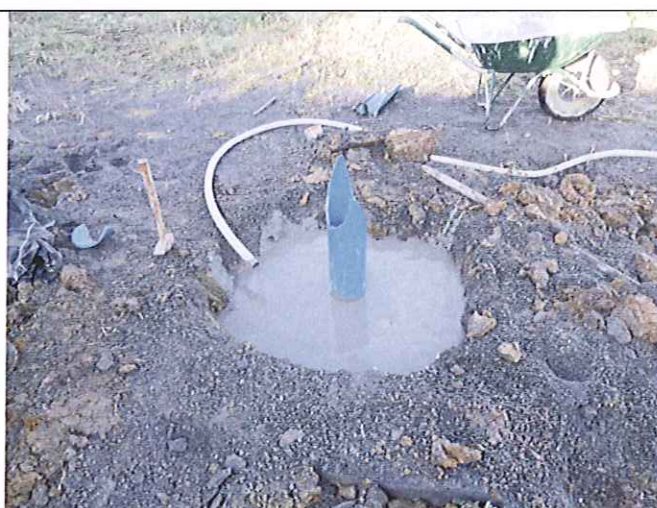
Photographie de l'ouvrage à l'issue de la cimentation
