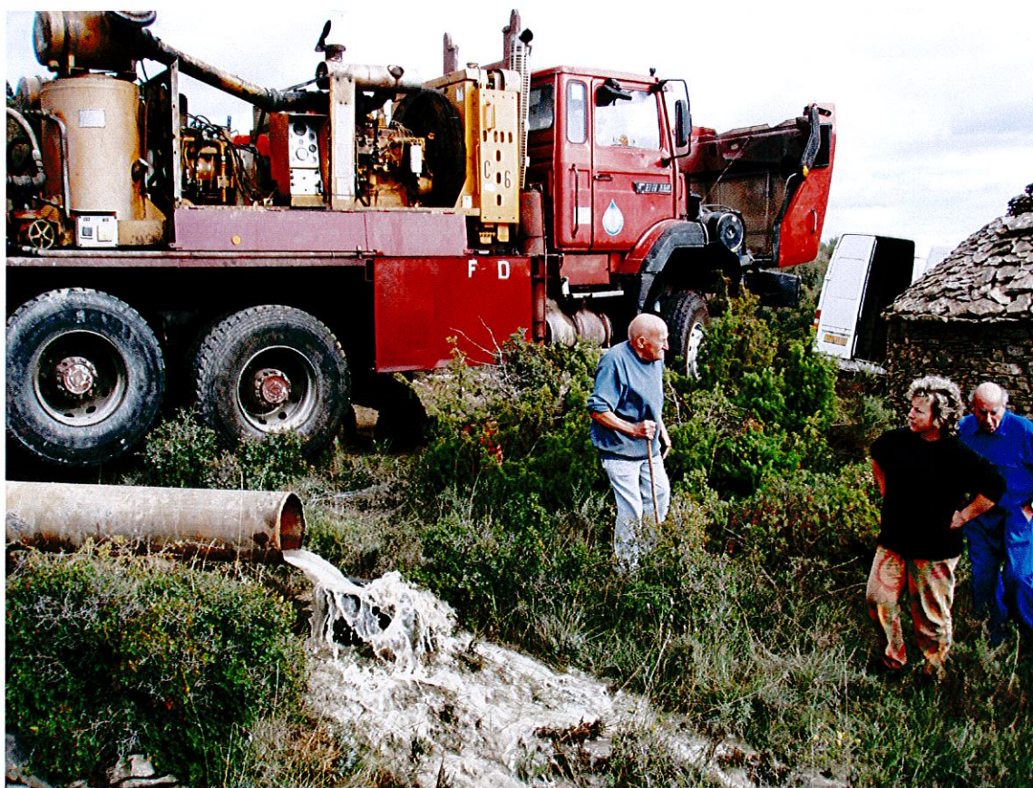
Soufflage à l'air lift à 145 m de profondeur - Q \approx 30 \text{ m}^3/\text{h} (04 octobre 2006)
