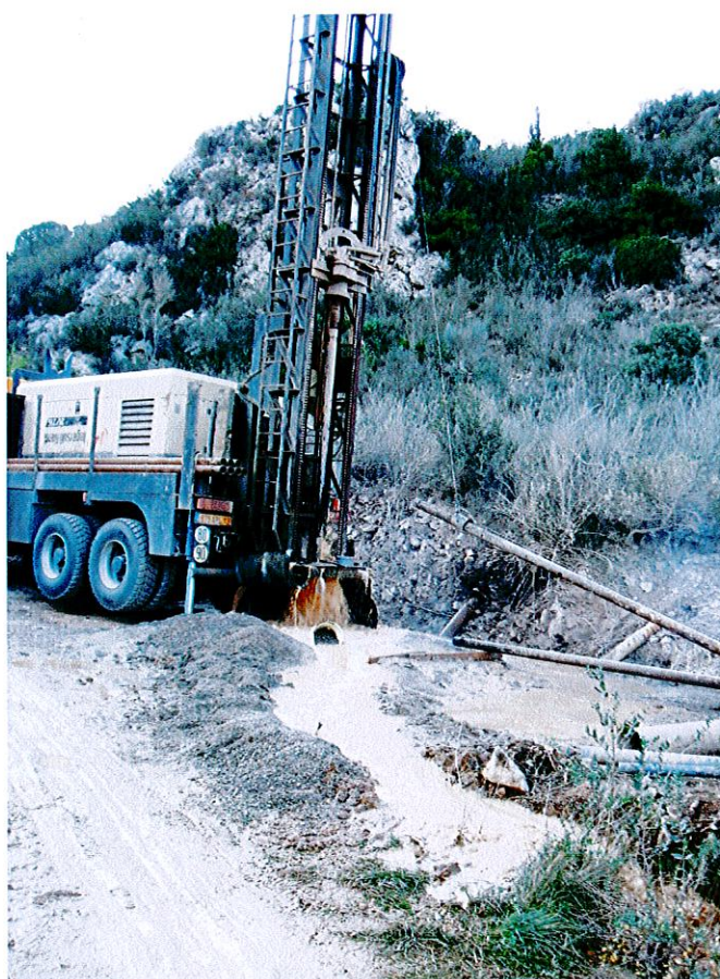
Foration à -170 m – Q \approx 15 \text{ m}^3/\text{h} (le 20/12/2006)
