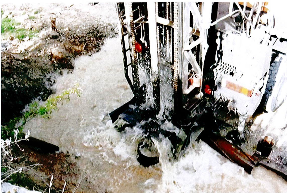
Forage des Douzes – Q \approx 100 \text{ m}^3/\text{h} à 70 m de profondeur (avril 2006)
