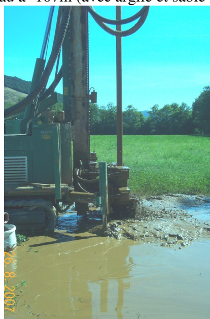
Arrivée d'eau à -107m (avec argile et sable dolomitique)
