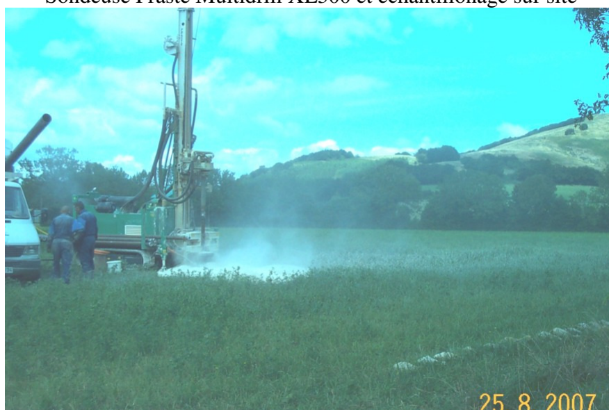
Arrivée d'eau à -107m (avec argile et sable dolomitique)
