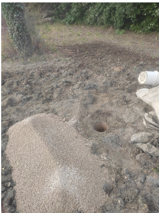
A gauche, vue du forage au cours du rebouchage. A droite, vue du forage rebouché.
