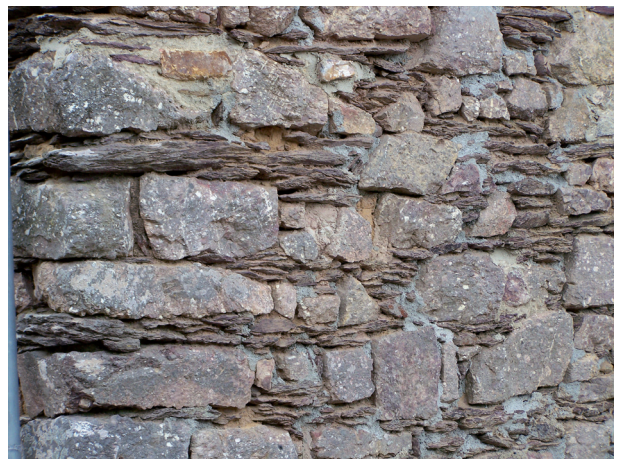
Photo. 23 - Maison construite en moellons de Poudingues de Montfort alternant avec des dalles de siltites rouges (Formation de Pont-Réan)
