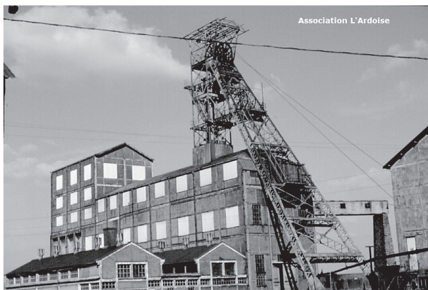
Fig. 16 - Le chevalement de la mine de fer de Bois III en 1986 (photo extraite du site internet « ardoise.free.fr » de l'association « l'Ardoise »)
